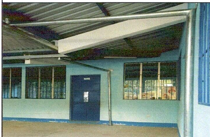
Foto 3: Instalación de bajadas de agua pluvial con tubería de metal, de los módulos, dirección, bodega y baños.
